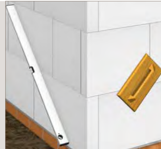
Kontrolle der Ebenheit der Oberfläche
