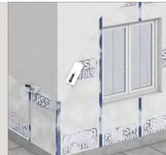
zweite Spachtelschicht
