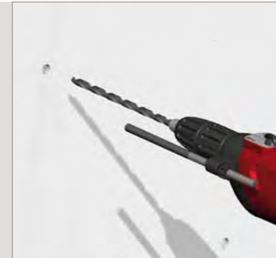
Bohrung mit 8 mm Bohrer
