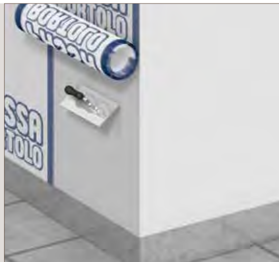
Spachtelung und Verlegung vom Armierungsgewebe Fassanet 160
