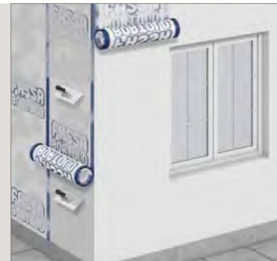
das Gewebe in die Spachtelung des Klebers FASSA A 96 einbetten
