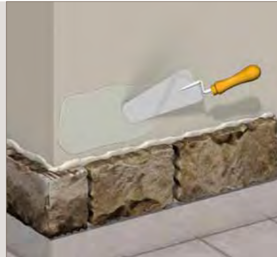
dünne Kleberschicht auch auf der Wand
