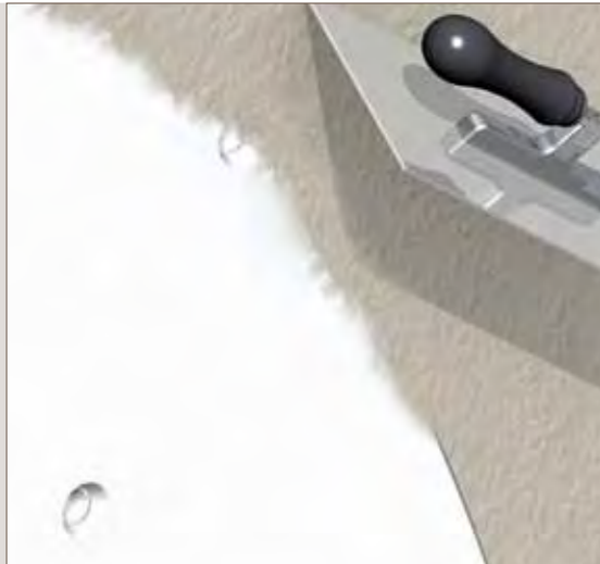
erste Spachtelung mit Kleber Geocoll
