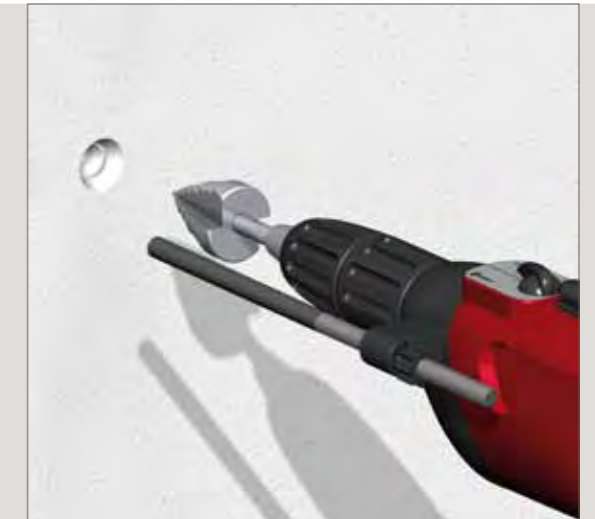
Fräsung mit 16-18 mm Durchmesser
