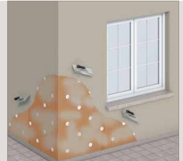
Abschluss der Stützspachtelung
